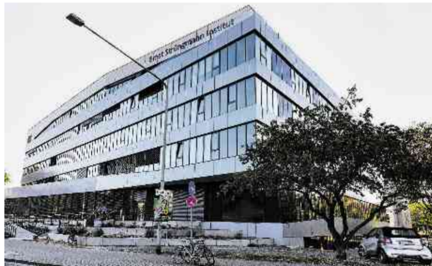
Profiliert: Das Institutsgebäude an der Deutschordensstraße Foto Wolfgang Eilmes
