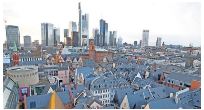
Blick vom Dom, 1961 und 2018: Wo mal Autos parkten, sind heute 35 Häuser wiederaufgebaut. Das Areal zwischen Dom und Römer dürfte die einzige Altstadt sein, die auf einer Tiefgarage steht. FOTOS: INSTITUT FÜR STADTGESCHICHTE/UWE DETTMAR
